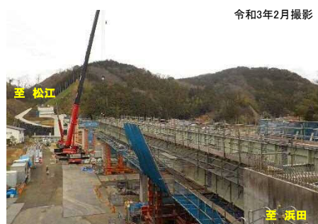
写真① 出雲・湖陵道路 東神西第2高架橋(仮称)付近の工事の様子
