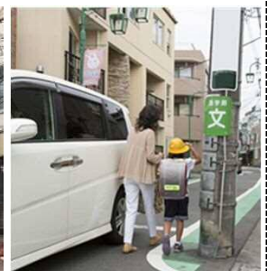
<歩行の支障となる電柱の事例>
