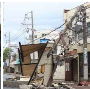
<飛来物による電柱倒壊の事例>
