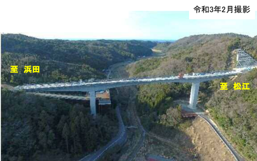
写真③ 静間・仁摩道路 逢浜川橋(仮称)付近の工事状況
