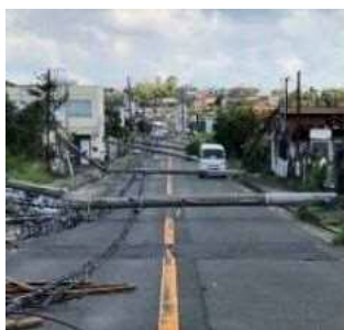
<電柱の倒壊による道路閉塞の事例>
