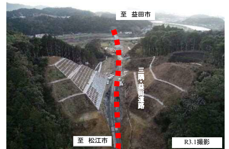
写真① 三保地区施工状況
