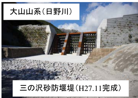
三の沢砂防堰堤(H27.11完成)
