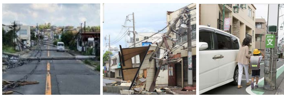
<電柱の倒壊による道路閉塞の事例> <飛来物による電柱倒壊の事例> <歩行の支障となる電柱の事例>
