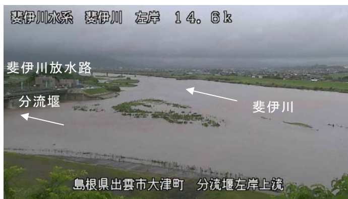
斐伊川放水路分流堰付近（7/7 10:30頃）
