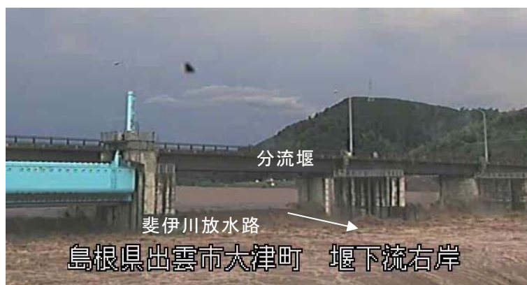
斐伊川放水路分流堰付近（7/12 14:00頃）
