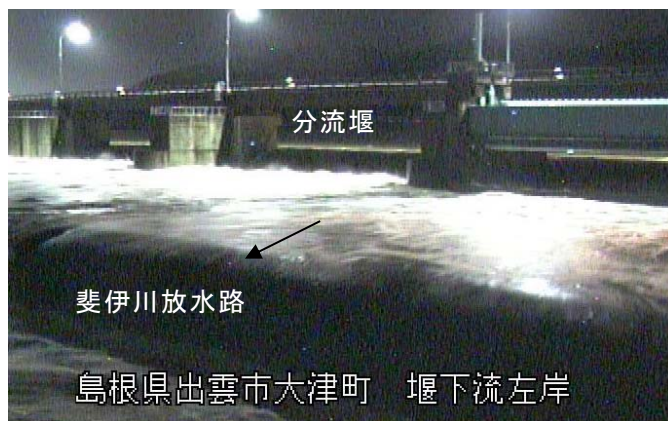
斐伊川放水路分流堰付近（8/14 23:00 頃）
