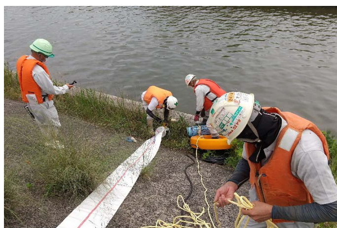
・排水ポンプ、ホース敷設作業
