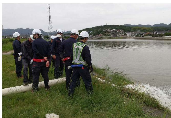
・排水ポンプ排水状況
