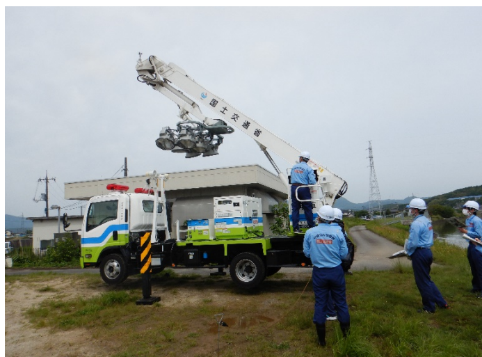
照明車（ブーム式） ・照明ブーム屈伸作業中
