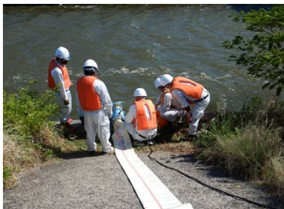
・排水ポンプ、ホース敷設作業
