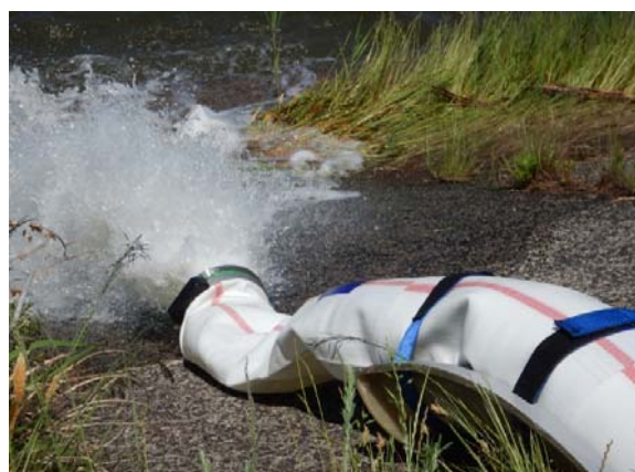
・排水ポンプ排水状況
