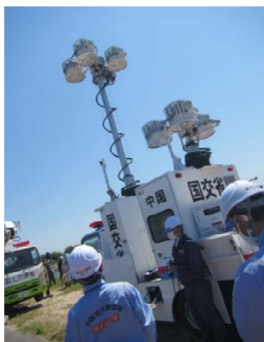
照明車 (ポール式) 照明ポール延 伸作業中
