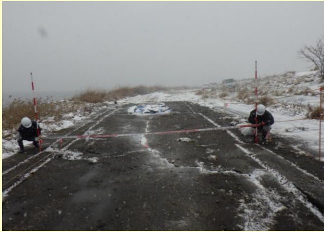
堤防の被災状況調査 (島根県松江市)
