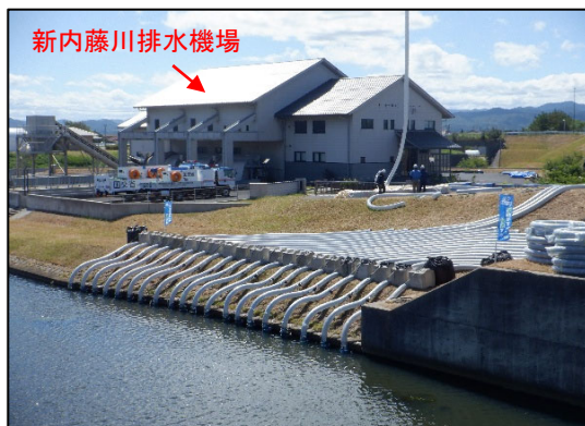
仮設ポンプ設置状況
