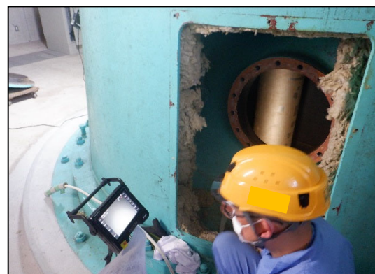
内視鏡によるポンプの詳細点検
