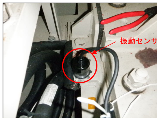
振動センサ取替状況近影
