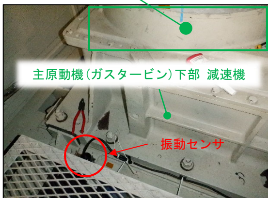
振動センサ設置状況(新品)
