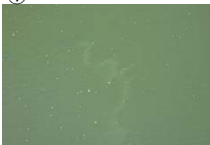
権現大橋から角井方向 (長さ 5m 幅 4m程度)に発生 (レベル2)
