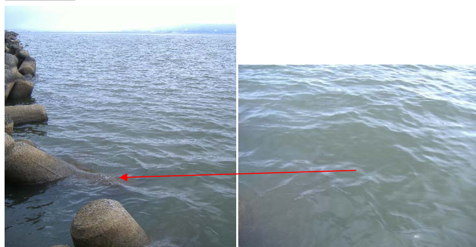
宍道湖北岸(松江市打出町)
