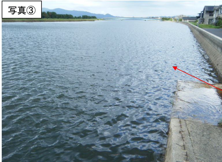
中海右岸(揖屋承水路)
