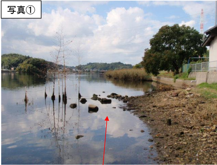
大橋川(松江市福富町)
