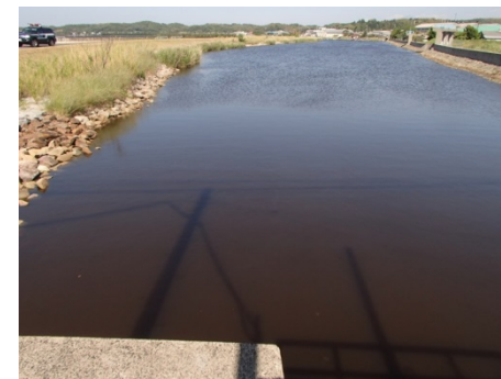
揖屋干拓承水路
