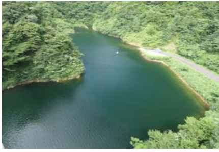
戸井谷大橋から左岸 筋状(長さ10m幅1m程度)に発生。(レベル2)
