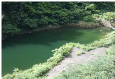
権現大橋上流部 筋状(長さ5m幅2m程度)に発生。(レベル2)
