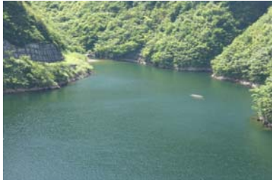
堰堤上流付近 右岸側 带状(長さ3m幅1m程度)に発生。(レベル2)
