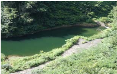
権現大橋上流部 面状(長さ5m幅5m程度)に発生。(レベル2)
