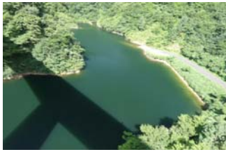
戸井谷大橋から左岸 筋状(長さ8m幅1m程度)に発生。(レベル2)
