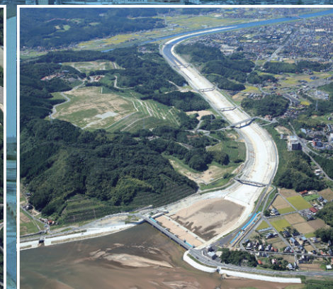
■ 斐伊川放水路（出雲市）
