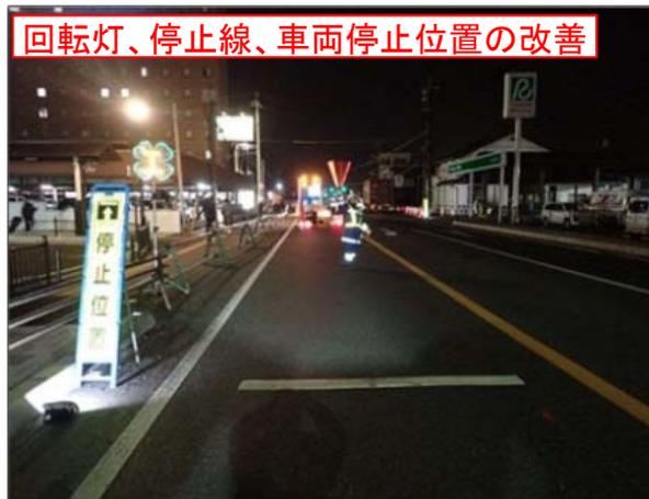
※ 回転灯が転倒しても停止車両に接触しない位置に停止位置を変更
