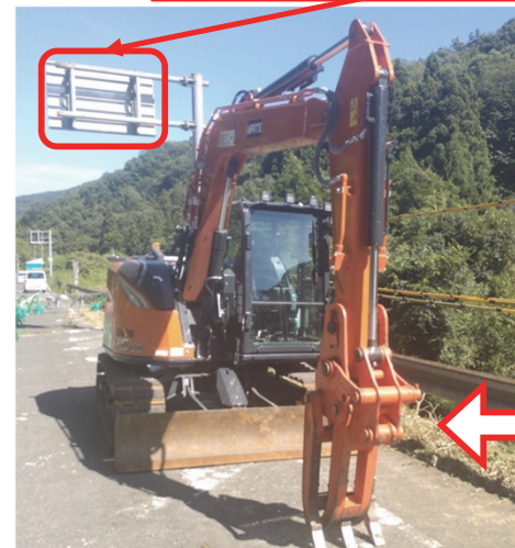
損傷した標識
