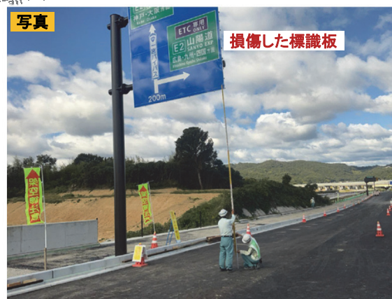
舗装面から標識板下端 H=5.3m
