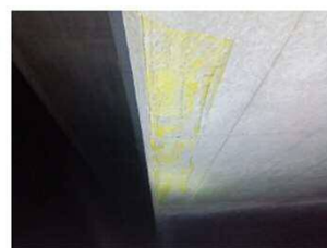
【損傷②】(寸法: 2100mm × 200mm)
