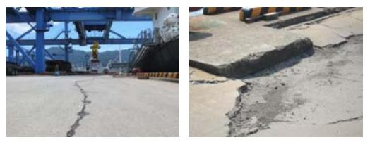
老朽化しエプロンに亀裂や段差が発生
