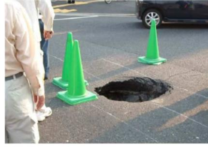
老朽化した下水管渠腐食に起因する道路陥没状況（広島市中区舟入南）
