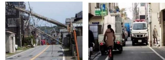
電柱倒壊等による道路閉塞防止のための無電柱化
