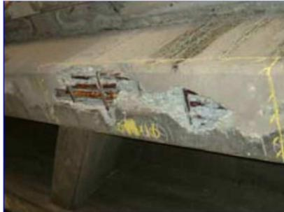
経年劣化及び中性化による主桁コンクリートの剥離及び鉄筋露出
