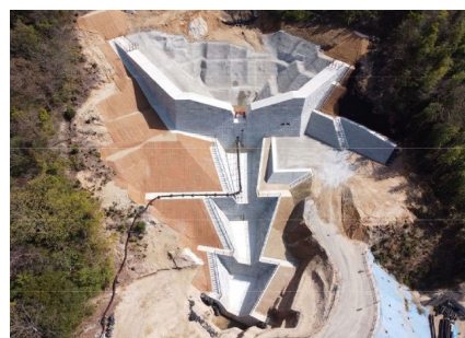
砂防堰堤の整備(呉市天応地区)
