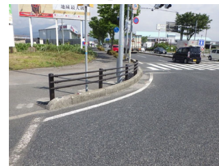
ガードレール設置(鳥取県)
