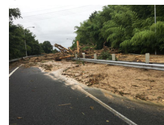
平成30年7月豪雨における土砂流入による車線閉塞(広島県道路)
