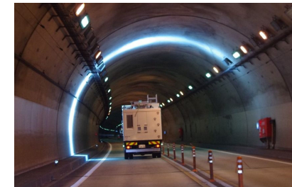
トンネル点検におけるひび割れ調査の自動化・効率化
