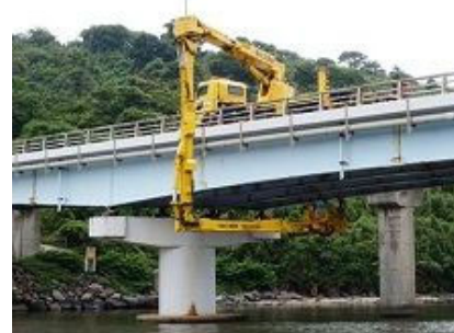
橋梁点検車による点検
