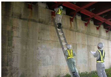
梯子による定期点検
