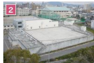
雨水滞水池による未処理放流の抑制
