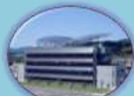
町庁舎の太陽光発電システム
