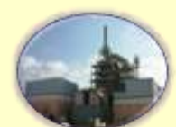
福山リサイクル発電 (株) 福山リサイクル発電所
