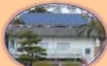
事務所棟太陽光発電システム
