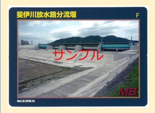
所 在 地:島根県出雲市大津町 川 名: 斐伊川水系斐伊川 式:可動堰 ー ト: 起伏ゲート×5門 制水ゲート×2門 長:200m 流 量:最大2000m/s 理 者:国土交通省 本体着工/完成年:2009/2013年 ランダム情報 ありますが、是非チャレンジしてみたいと いう提案がありましたら、右記アドレスま で応募してみては如何でしょうか。 こだわり技術 斐伊川は網状砂州の発達した典型的な砂河川であり、分流堰の 直下流に沈砂池を設けることによって、洪水時に斐伊川の砂が 神戸川に流れ、堆積することを防ぎます。
