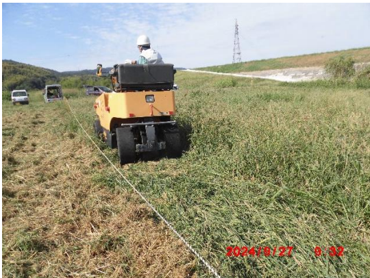
ロードローラーによる繁茂抑制
