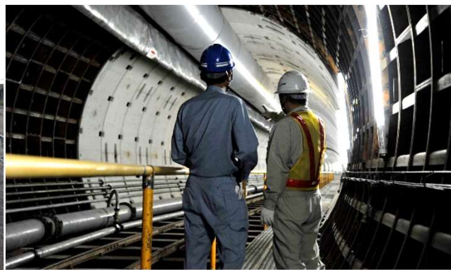
雨水貯留管の整備
