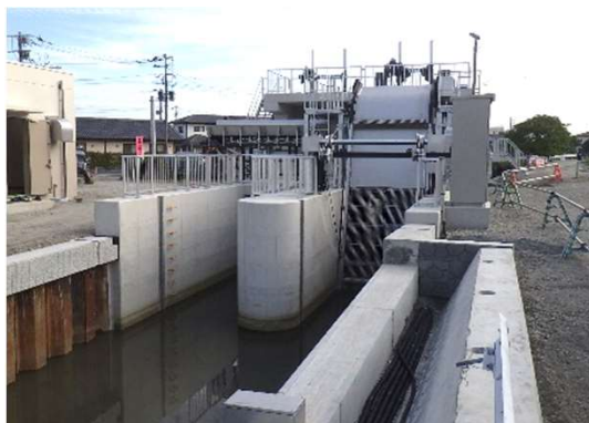
雨水ポンプ場の整備
