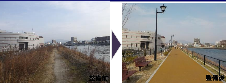
↑ 公園(河岸緑地)に園路・街路灯等を整備(広島県広島市)
