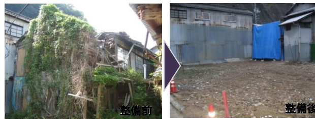
↑ 倒壊の危険のある建物を除却(広島県大崎上島町)
