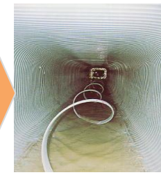
↑ 下水道管渠の老朽化対策 (特殊な部材による内面を被覆)
