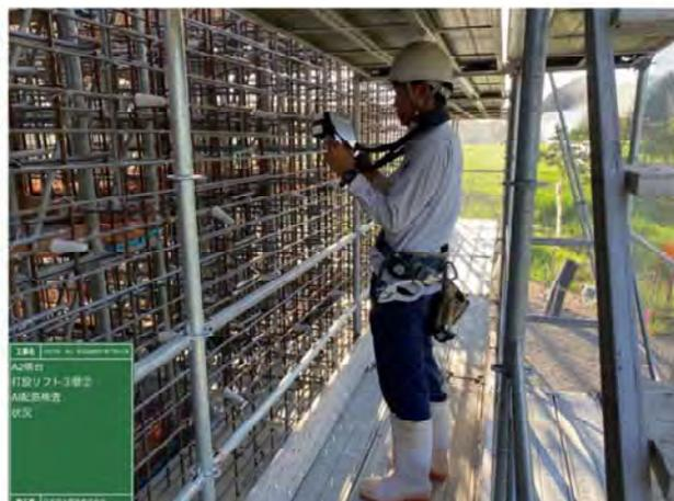
図 5 AI 技術を用いた検査状況
