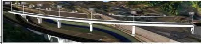
第1案モデル：鋼6径間連続合成細幅箱桁橋
