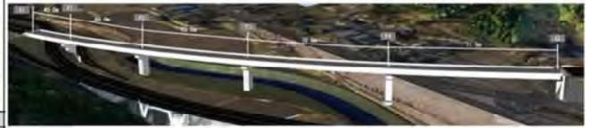
第2案モデル：鋼5径間連続合成細幅箱桁橋
