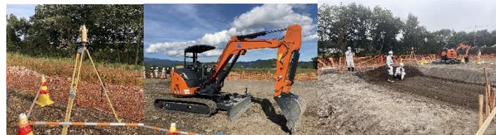
重機への機器設置作業は平均1時間程度（工場で取付け治具の事前溶接・キャリブレーションをしておけば現地作業を10分程度に短縮可能）
