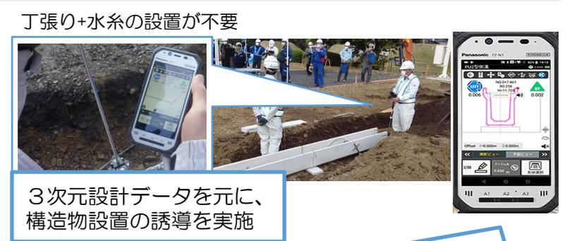
水平離れ、観測点法長などをリアルタイムに確認しながら構造物の誘導/据え付けが可能
