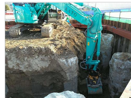
チルトローテータでの狭隘部の掘削状況
