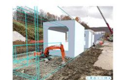
掘削作業時にARと比較
