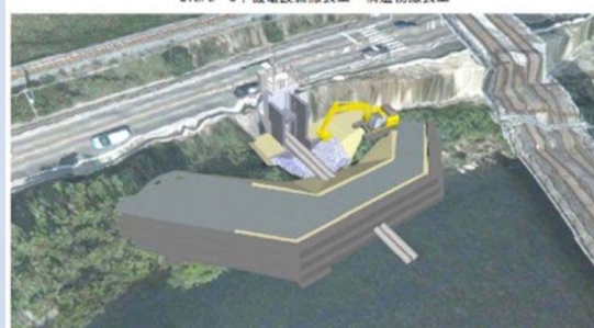
STEP4～5：樋門躯体工。川底角落し工～護岸復旧工
