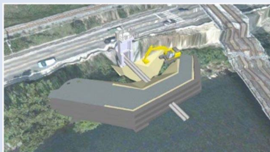
STEP2～3：機電設備撤去工～構造物撤去工
