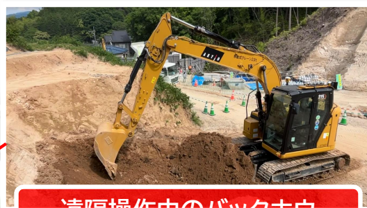
遠隔操作中のバックホウ
