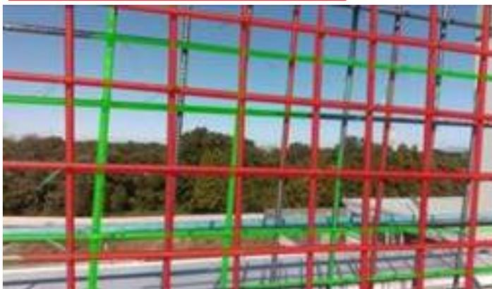
画像からAI機能で鉄筋の上段(赤)・下段(緑)を抽出して、表示します。抽出したい対象の鉄筋を選択することで、ダブル配筋の鉄筋が計測可能です。
