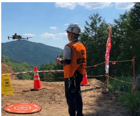
元請け職員による3次元測量
