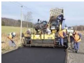
低炭素アスファルト
