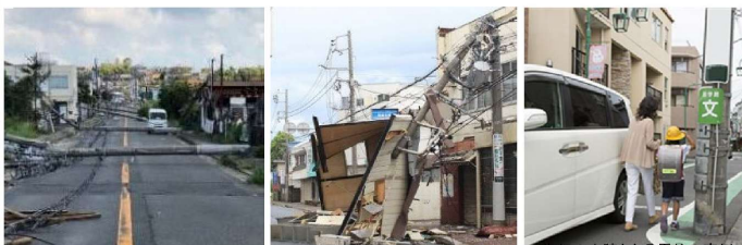
＜電柱の倒壊による道路閉塞の事例＞ ＜飛来物による電柱倒壊の事例＞ ＜歩行の支障となる電柱の事例＞
