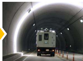
走行型画像計測による点検
