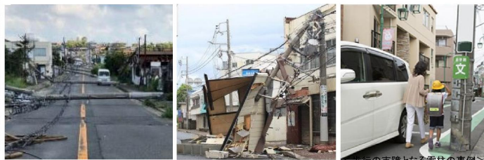
＜電柱の倒壊による道路閉塞の事例＞ ＜飛来物による電柱倒壊の事例＞ ＜歩行者の支障となる電柱の事例＞
