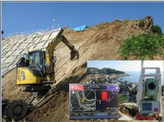
3D管理による特殊法面掘削工法
