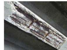
主桁の損傷 (ひび割れ・剥離・鉄筋露出)
