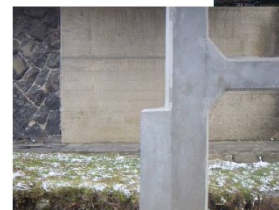
橋脚の補修(断面修復工)
