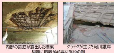
内部の鉄筋が露出した橋梁 早期に措置が必要な施設の例
