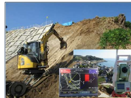
3D管理による特殊法面掘削工法
