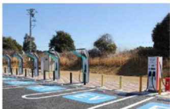
浜松サービスエリア（静岡県浜松市）
