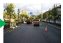
道路舗装（表層・基層）
