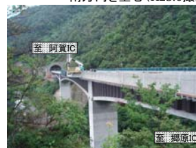
【写真③】小滝川橋付近から南方向を望む (H23.8撮影)
