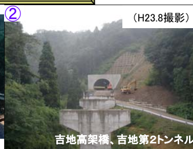
進捗状況写真
