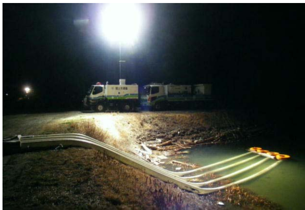
排水ポンプ車・照明車の活動状況
