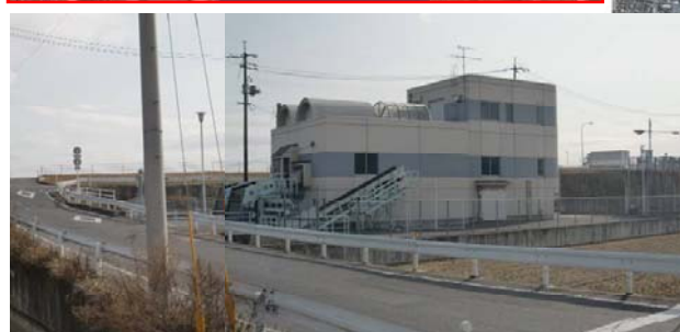
既存の倉安川排水機場 (H5年度に排水量 Q=2.5\text{m}^3/\text{s} のポンプを整備済)
