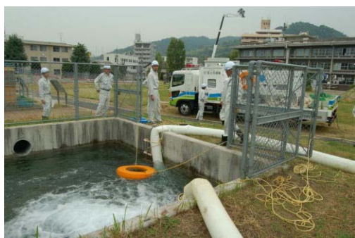
排水ポンプ車設置訓練状況(平成23年6月)
