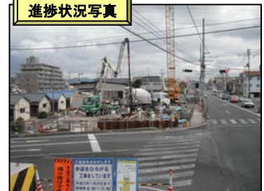
進捗状況写真
