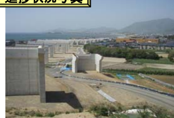
写真③工事施工状況(綾羅木地区)H23.5
