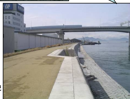
高潮堤防の整備状況 （元安川出島地区）
