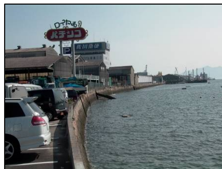
高潮堤防の整備前 （元安川出島地区）
