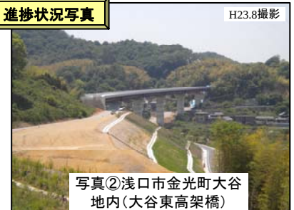
進捗状況写真
