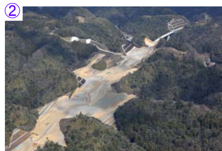
島根県大田市温泉津町温泉津地内 温泉津IC(仮称)付近 (東側を望む) H23.3撮影
