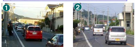
■国道188号現道区間の歩道未設置箇所の状況
