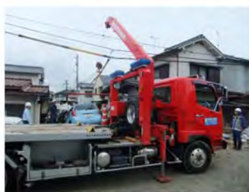
土砂撤去作業
