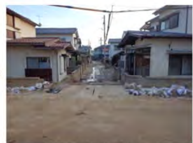
土砂撤去状況
