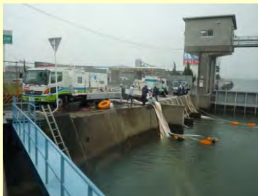
羽原川(福山市)排水ポンプ車設置状況
