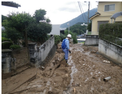
道路への土石流の流出状況
