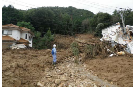
家屋の被災状況
