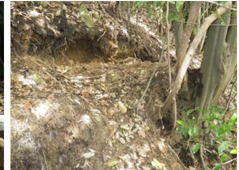
溪岸の不安定土塊の状況
