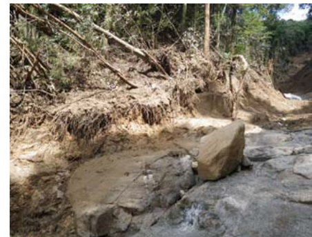
溪岸の残存土塊の状況
