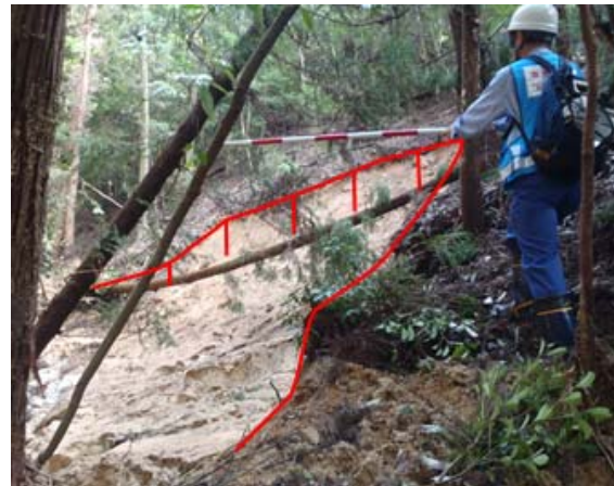
溪岸の崩壊状況(2)
