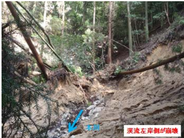
溪岸の崩壊状況(1)
