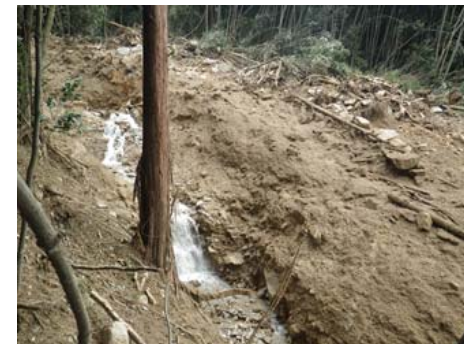
住宅地上流の流路付近の表層土流出状況
