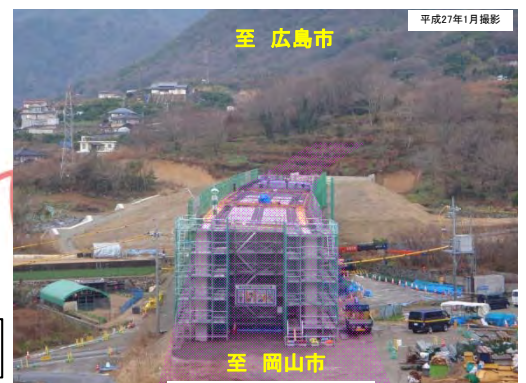
写真①内畠高架橋
