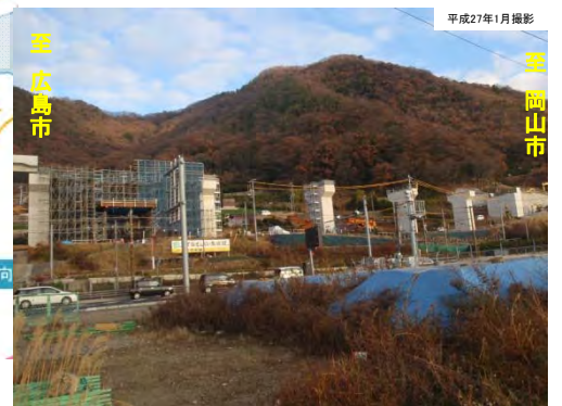
写真②下木原第1高架橋
