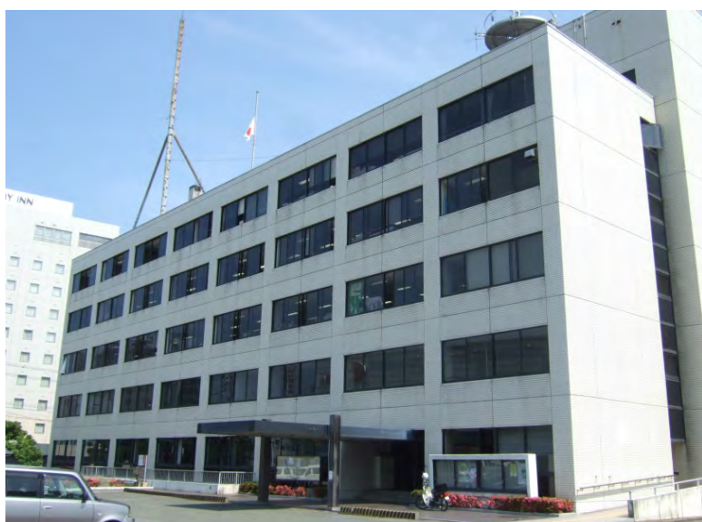
下関地方合同庁舎現況外観
