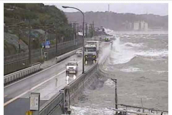
写真 台風18号による越波(H16.9.7)
