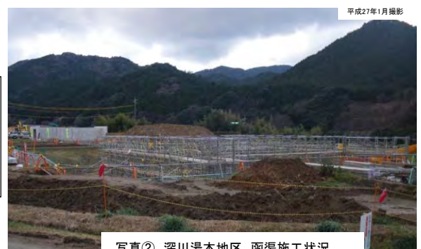
写真② 深川湯本地区 函渠施工状況
