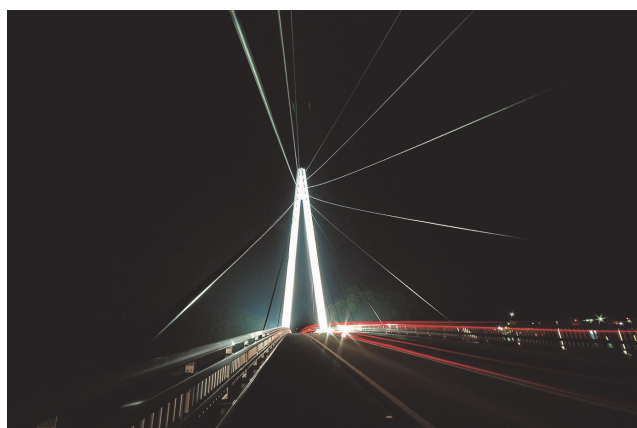
ライトアップしたマリン大橋
