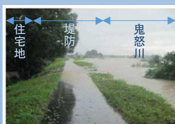
川の水位が堤防を超えたところ
